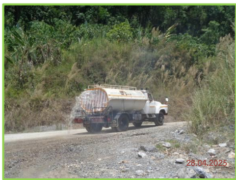
ภาพที่ 2-7 การฉีดพรมน้ำเพื่อลดการฟุ้งกระจาย ของฝุ่นละออง
